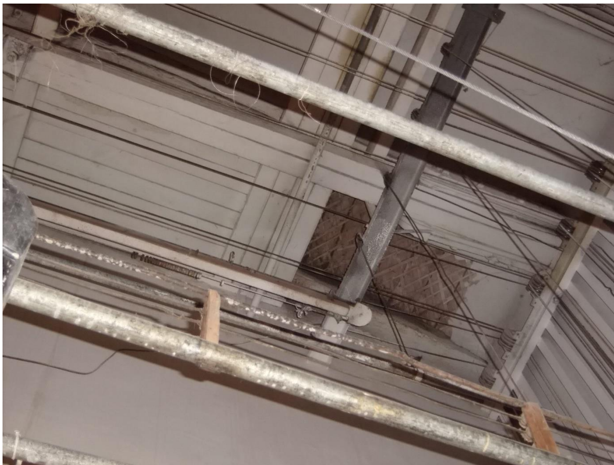
Фото 31. Чердачное перекрытие над сценой (фото 2013 года, предоставлено работниками дворца)
