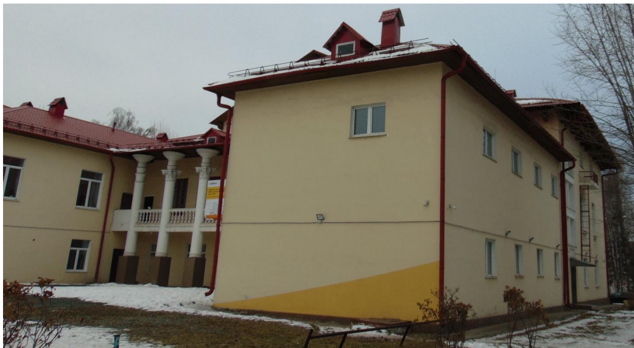
Фото 7. Литера А. Фасад в осях Н-А
