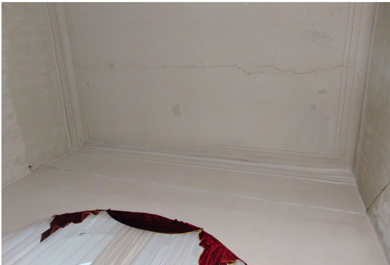
Фото 33. Лестничная клетка в осях 1-5/Д-Е
