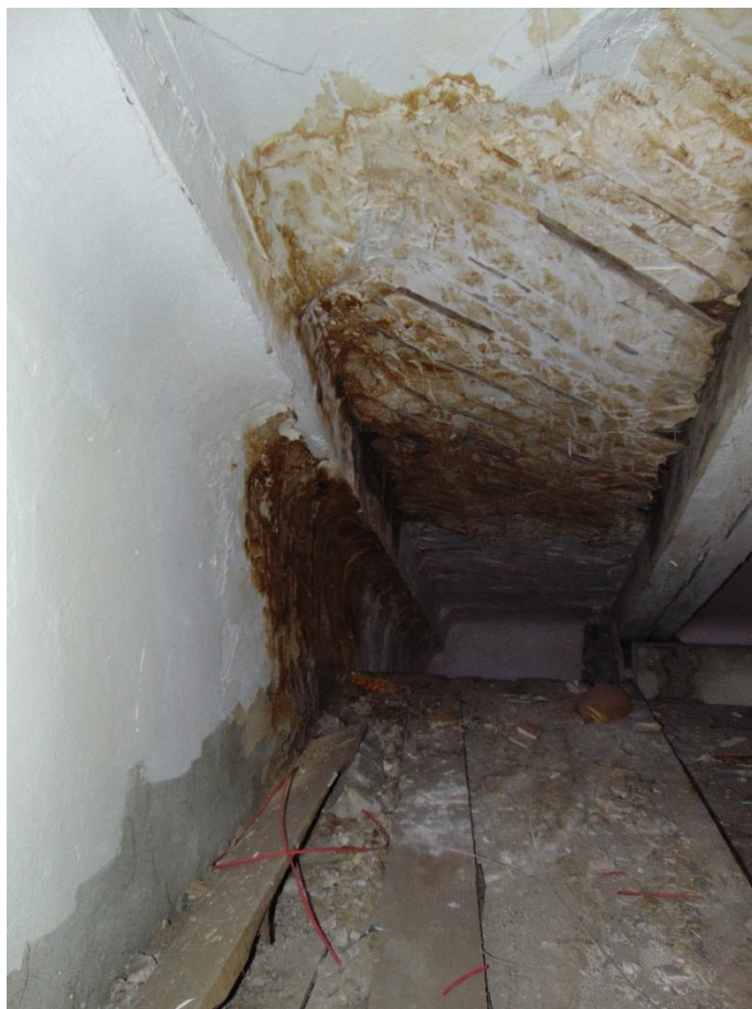
Фото 25. Чердачное перекрытие над сценой
