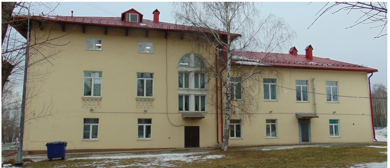
Фото 3. Литера А. Фасад в осях А-Н
