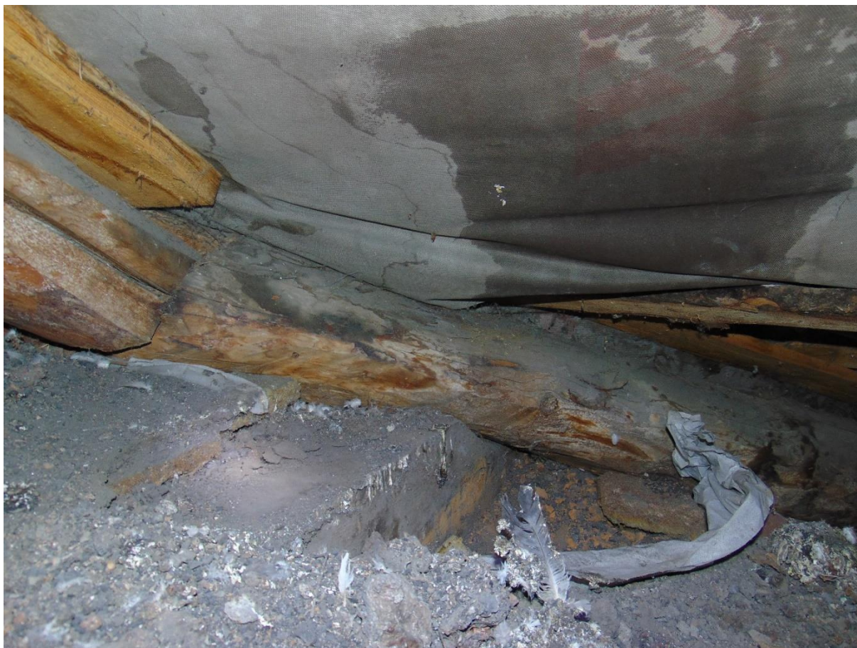
Фото 29. Чердачное перекрытие над сценой (чердак)
