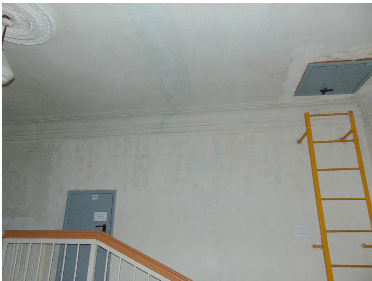
Фото 34. Лестничная клетка в осях 1-5/Д-Е
