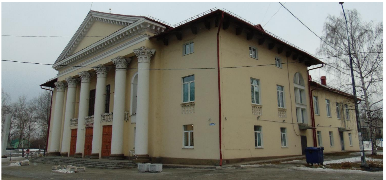
Фото 2. Литера А. Фасады в осях 1-13, А-Н
