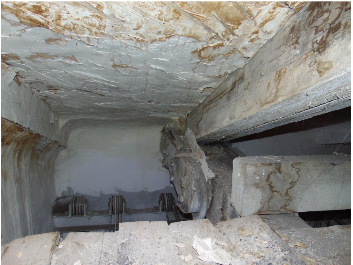
Фото 27. Чердачное перекрытие над сценой
