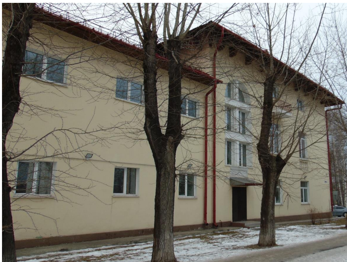
Фото 8. Литера А. Фасад в осях Н-А
