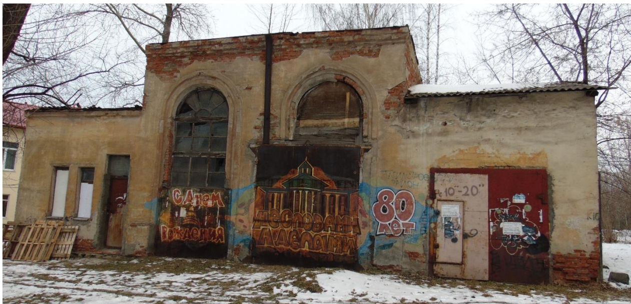
Фото 9. Литера Б. Фасад в осях 1-3
