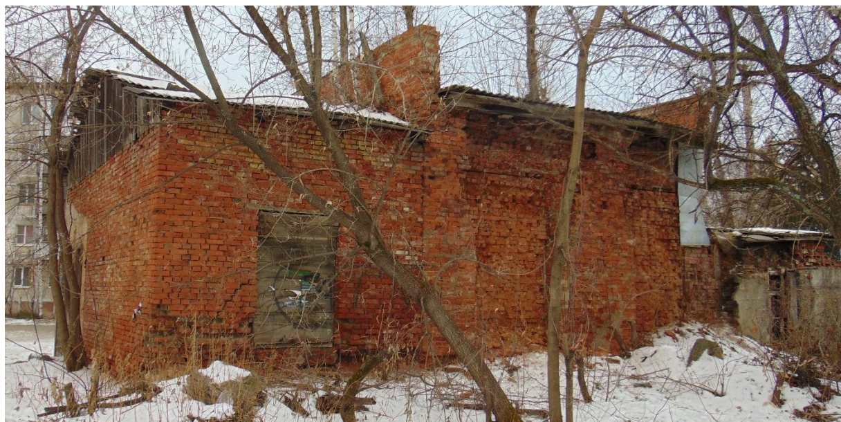
Фото 11. Литера Б. Фасад в осях 3-1
