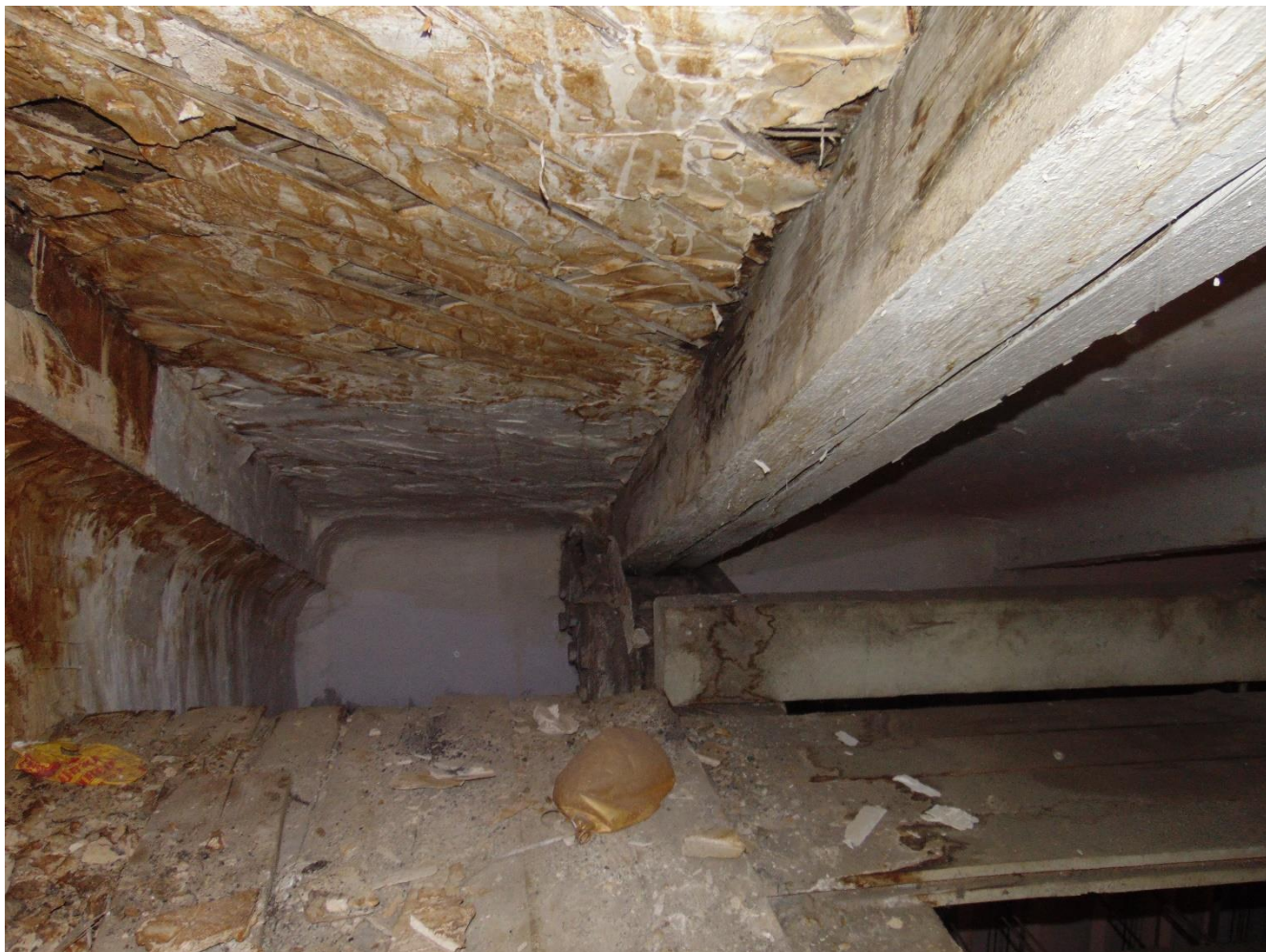
Фото 26. Чердачное перекрытие над сценой
