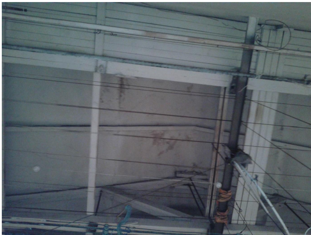
Фото 30. Чердачное перекрытие над сценой (фото 2013 года, предоставлено работниками дворца)
