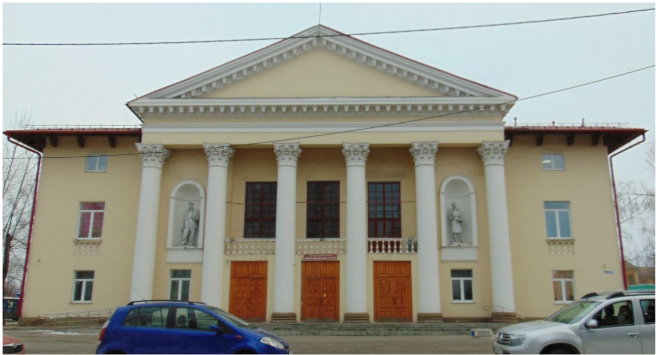
Фото 1. Литера А. Фасад в осях 1-13
