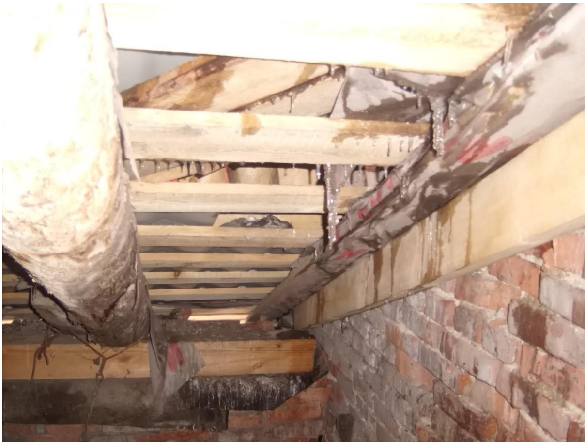
Фото 23. Чердак над хореографическим залом (фото 2008 года, предоставлено работниками дворца)
