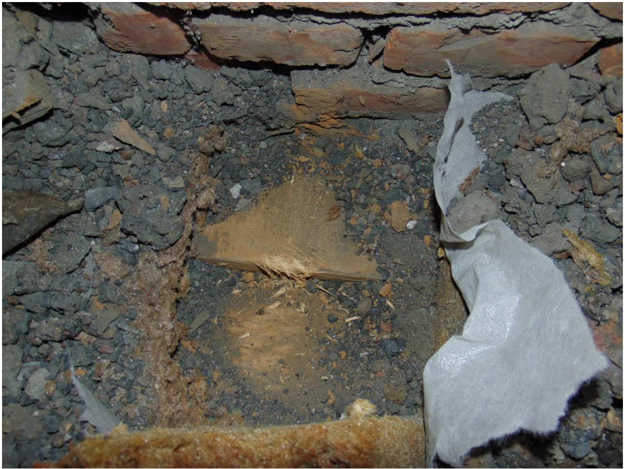
Фото 28. Чердачное перекрытие над сценой (чердак)
