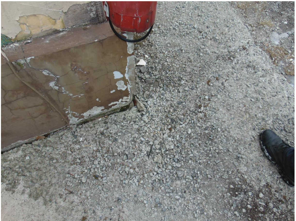
Фото 17. Повреждение отмостки
