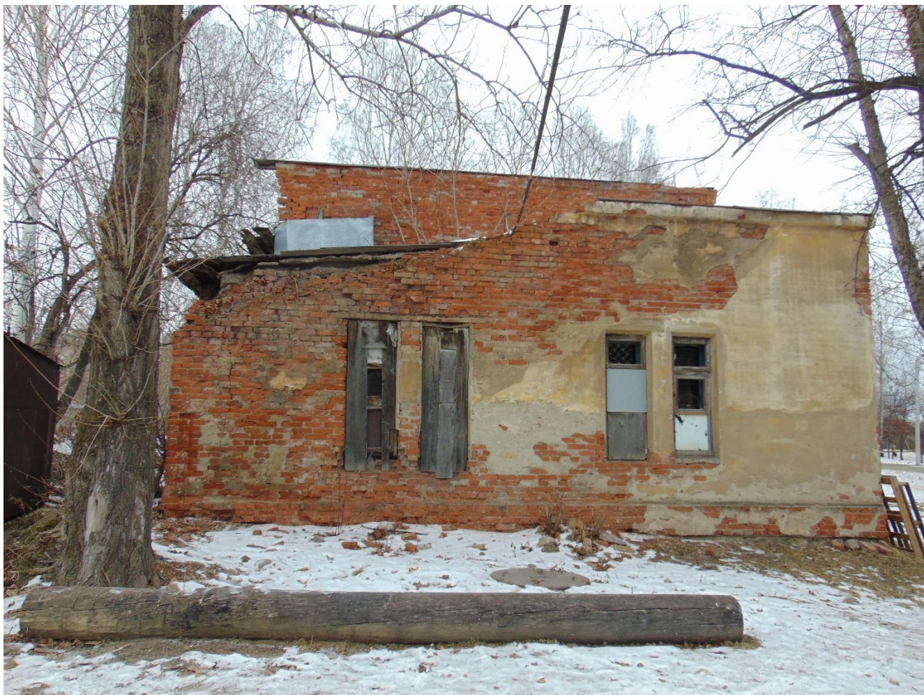
Фото 12. Литера Б. Фасад в осях Б-А
